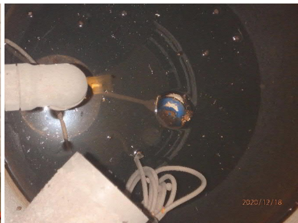
Kuva 6. Luotsin läntisen hissien pumppauskaivo sijaitsi talovaraston lattiassa.
