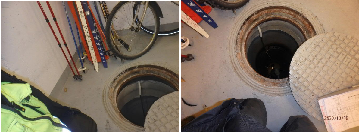
Kuva 7. Kolmas hissikaivo sijaitse Luotsin ulkoiluvälinevaraston lattiassa.
