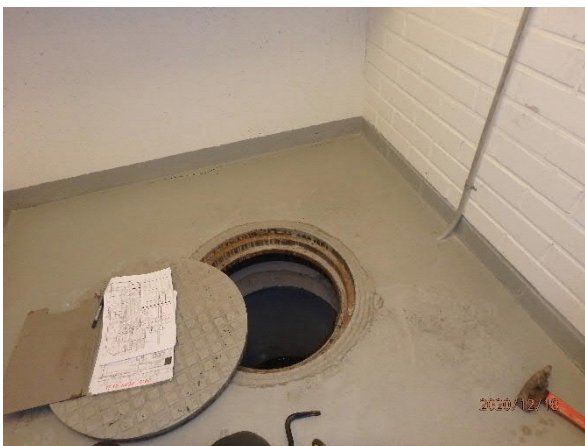
Kuva 6. Luotsin läntisen hissien pumppauskaivo sijaitsi talovaraston lattiassa.
